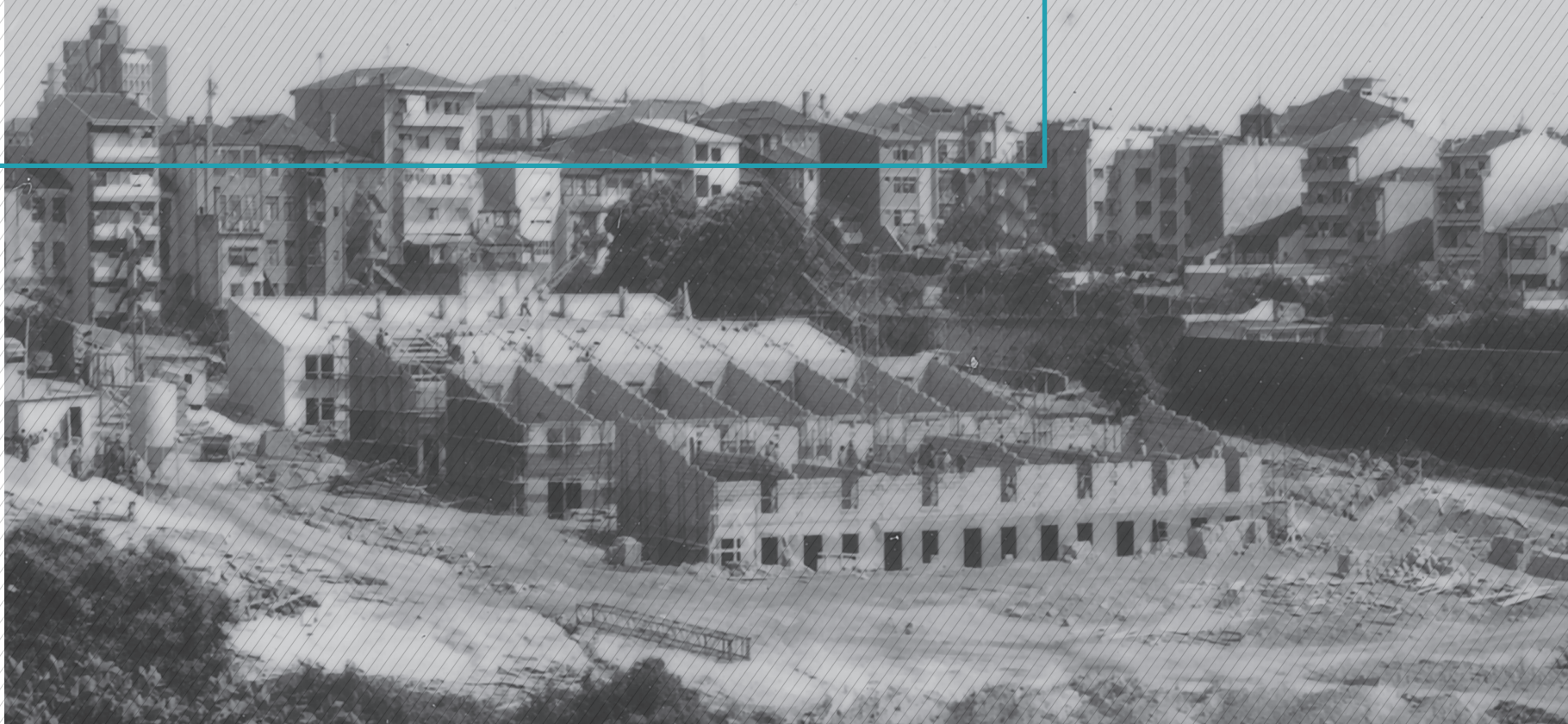
OPERAÇÃO SAAL_LAPA. ÁREA DE EXPANSÃO. NOVOS EDIFÍCIOS EM FASE DE CONSTRUÇÃO, 1976. FOT. DE A MATOS FERREIRA.
